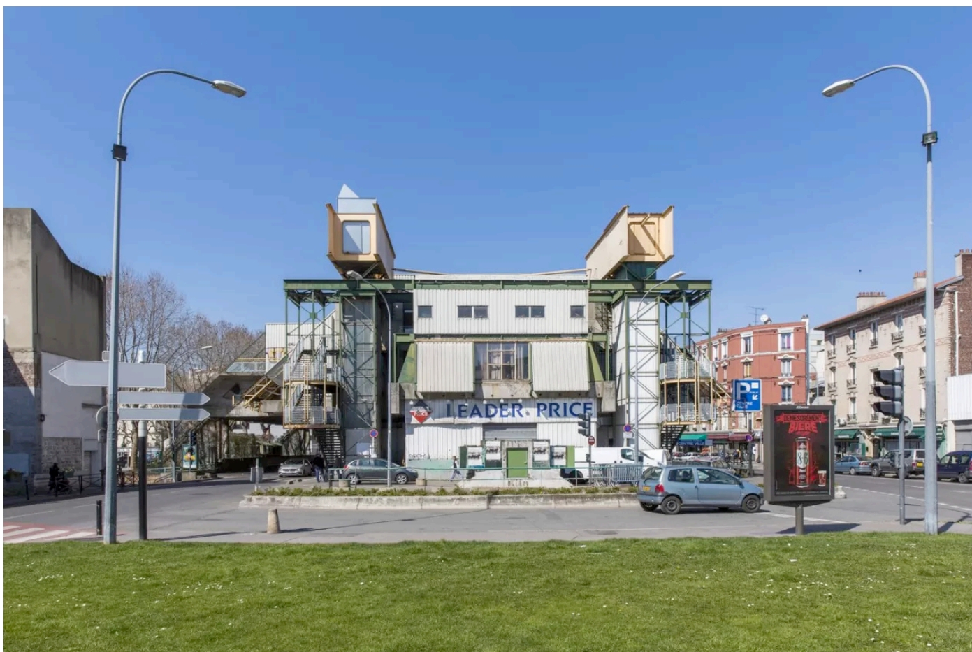
Paul Chemetov, Façade sud-est de la patinoire, Saint-Ouen (Seine-Saint-Denis), 2015 © Alexandra Lebon / Cité de l'architecture et du patrimoine
